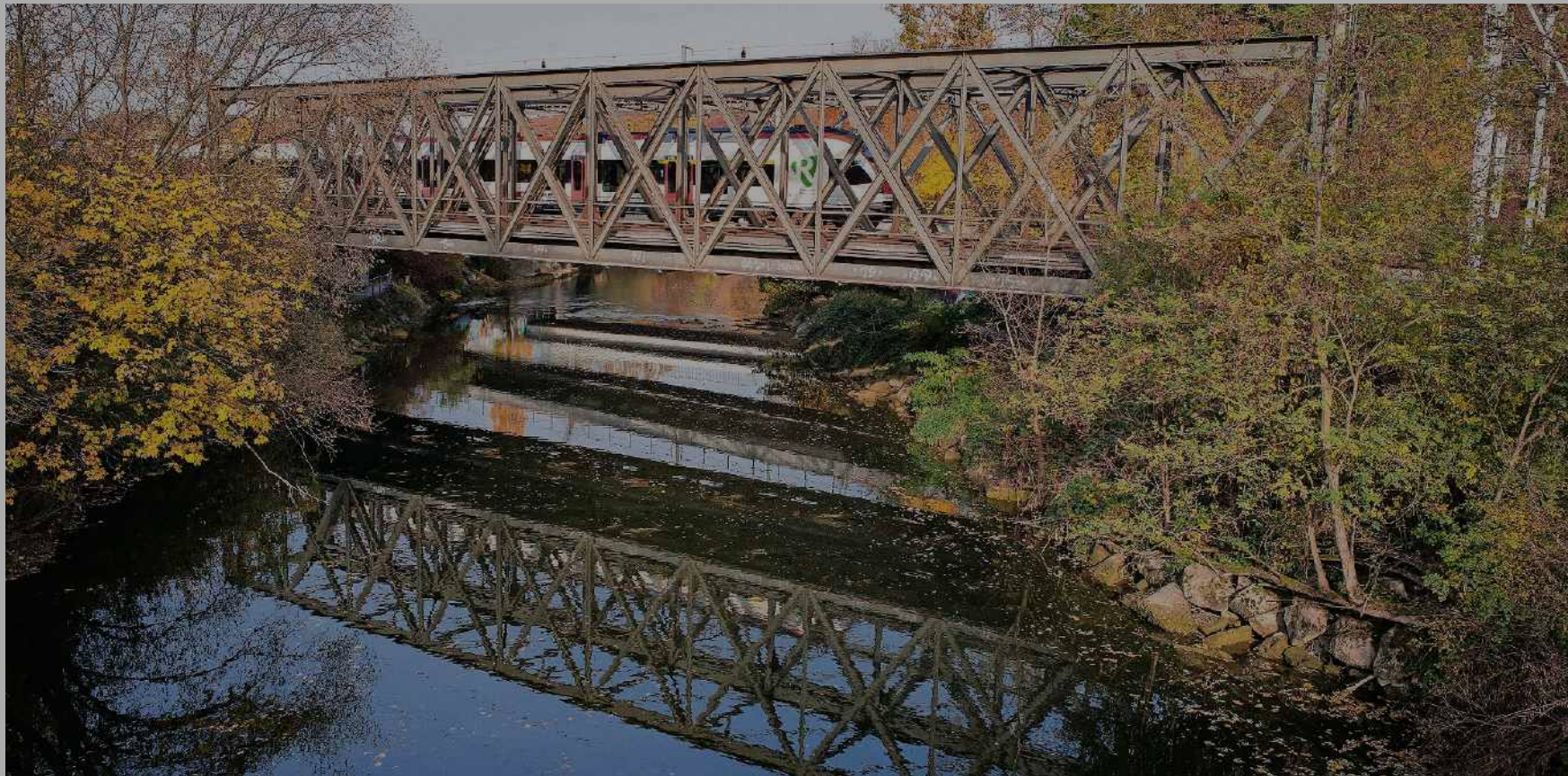
An der 1882 erbauten Eisenbahnbrücke in Münchenstein wurde eine Methode getestet, mit der man demnächst in Australien eine Brücke saniert.
