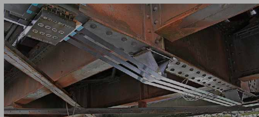
Festklemmen, Stützen drunter, fertig: Was simpel erscheint, erforderte eine Entwicklungszeit von vier Jahren.
