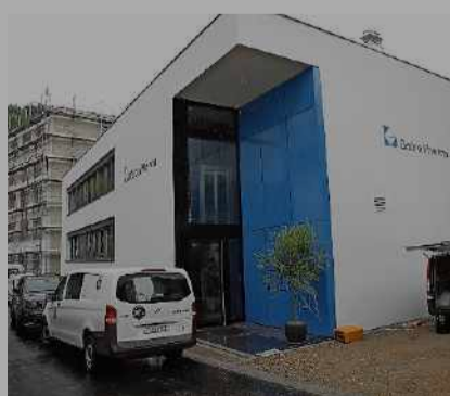
Neubau der Gebro Pharma in Liestal HI
